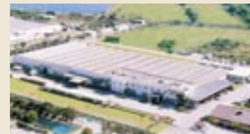
泰国いすゞエンジン製造株式会社
