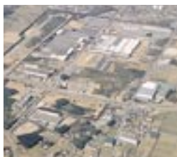
栃木工場 全景
