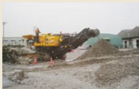
コンクリートガラの再生状況
